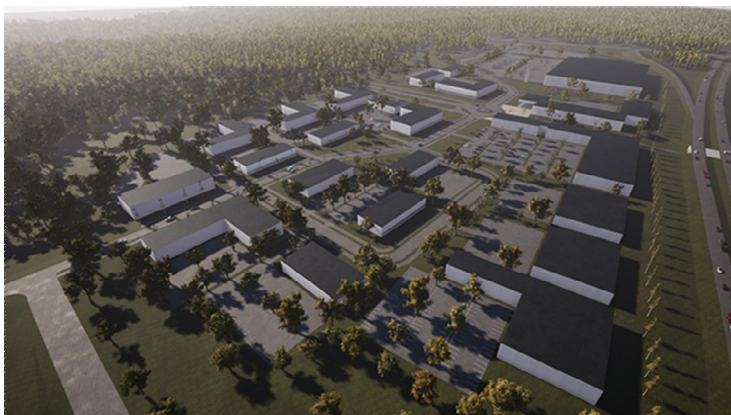
Kuva 25. Näkymä poh- joiseen.
